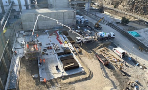
Projet «Flame» à Éclépens: construction de deux halles de stockage et adaptation du four pour valoriser des résidus plastiques non recyclables.
